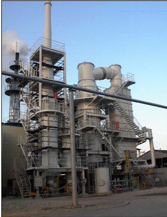
左:スクラバ, 中央:冷却塔, 右:再燃焼室
