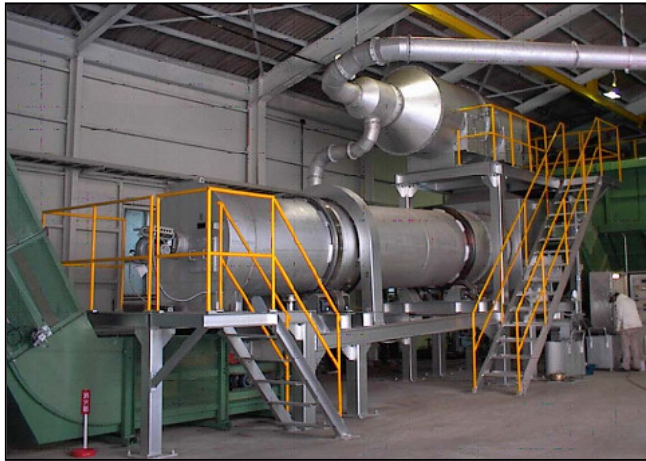
ロータリーキルン及び再燃焼炉(上部)
