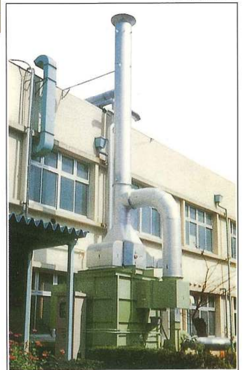
触媒燃焼方式
